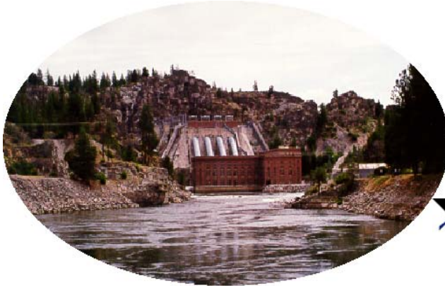
Long Lake Powerhouse - 1999
